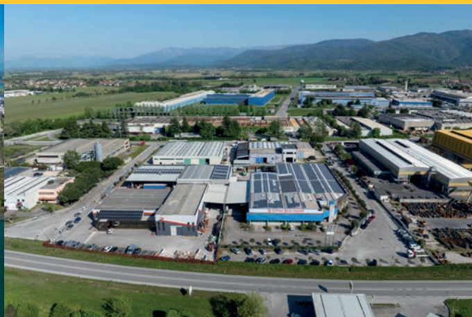
ZONA INDUSTRIALE CIVIDALE
